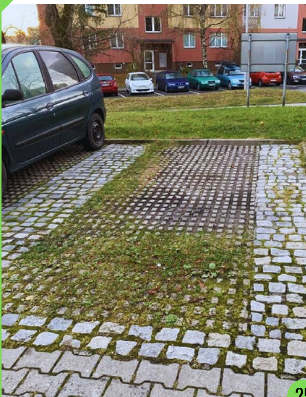
Zpevněná plocha propustná
