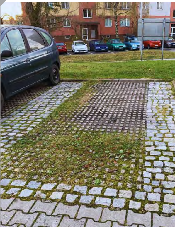
Zpevněná plocha propustná
